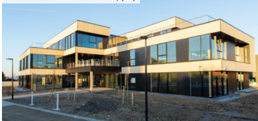
La Pilaterie – Villeneuve-d'Ascq (59)
